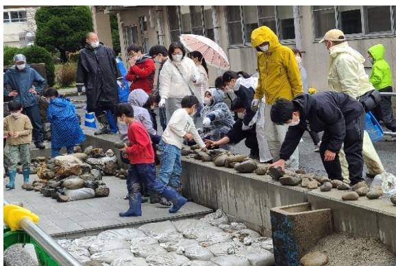
池底の基礎作り
