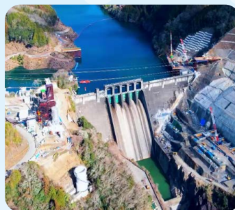
新丸山ダム工事現場 (岐阜県加茂郡八百津町)
