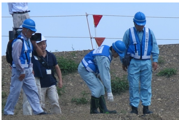
（点検箇所の状況報告）
