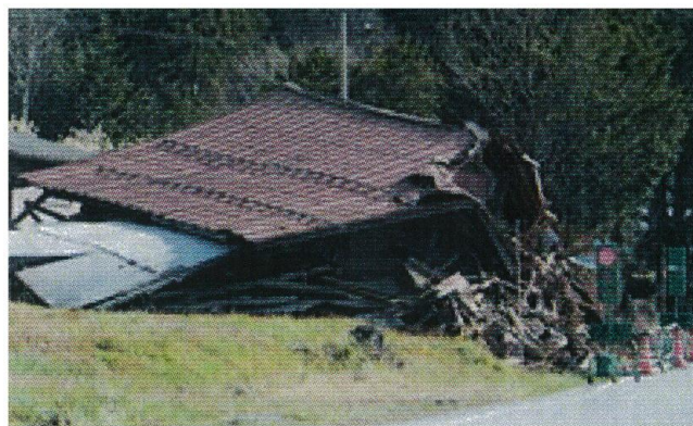
地震による倒壊家屋
