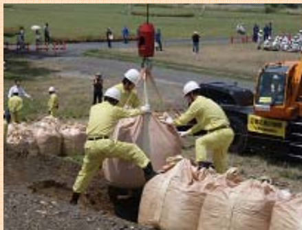
大型土のうの設置
