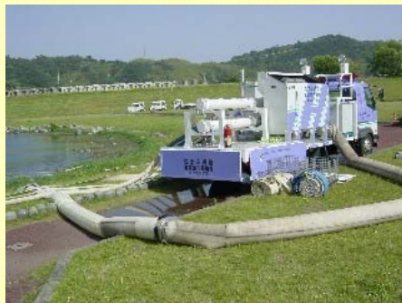
排水ポンプ車による排水
