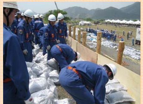
改良せき板工
