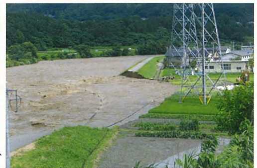
松島北島地先の破堤直後
