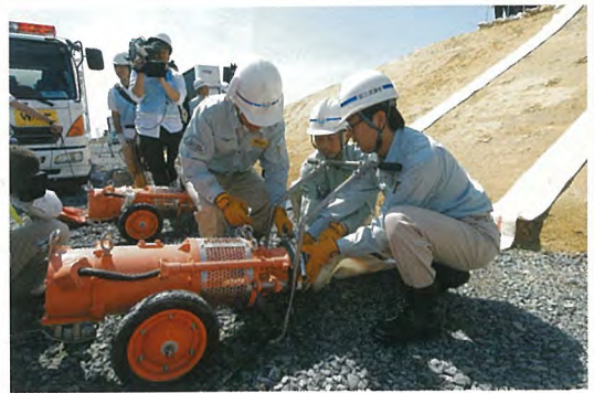
排水ポンプ車の設置訓練
