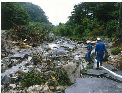
寸断された道路
